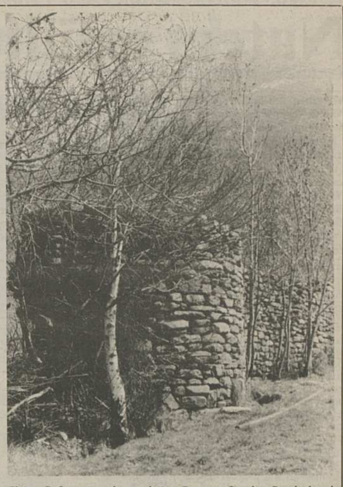
Keine Sofortmassnahmen, keine Rettung für das Baudenkmal von nationaler Bedeutung. Inzwischen sind die Zinnen und der Wehrgang vom Verfall bereits eingeholt worden. Zudem hat auch das Wurzelwerk der Bäume seine schädigende Wirkung getan.
