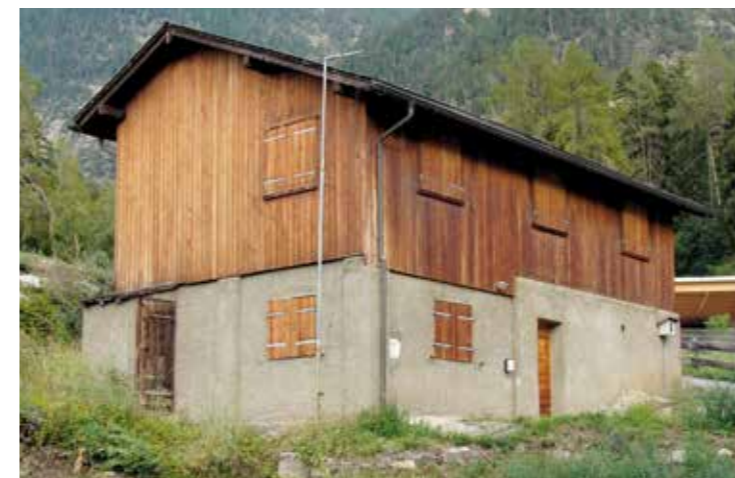
Südwestseite des Schützenstand
