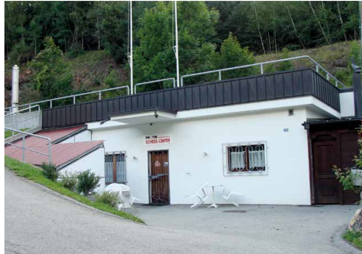
Eingangsbereich zum Schiesskeller «Pro Tir» in Glis
