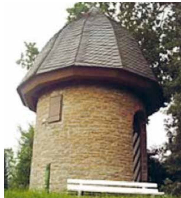
Ein Pulverturm (auch Pulvermagazin genannt, gelegentlich auch Pulverhaus) ist ein militärisch oder bergbaulich genutztes Bauwerk, häufig ein Turm, zur Aufbewahrung von Schiesspulver oder später Sprengstoff, was bis in das 20. Jahrhundert üblich war. Gefürchtet war die Explosion eines Pulverturms, wie sie sich etwa beim Delfter Donnerschlag zugetragen hat.
