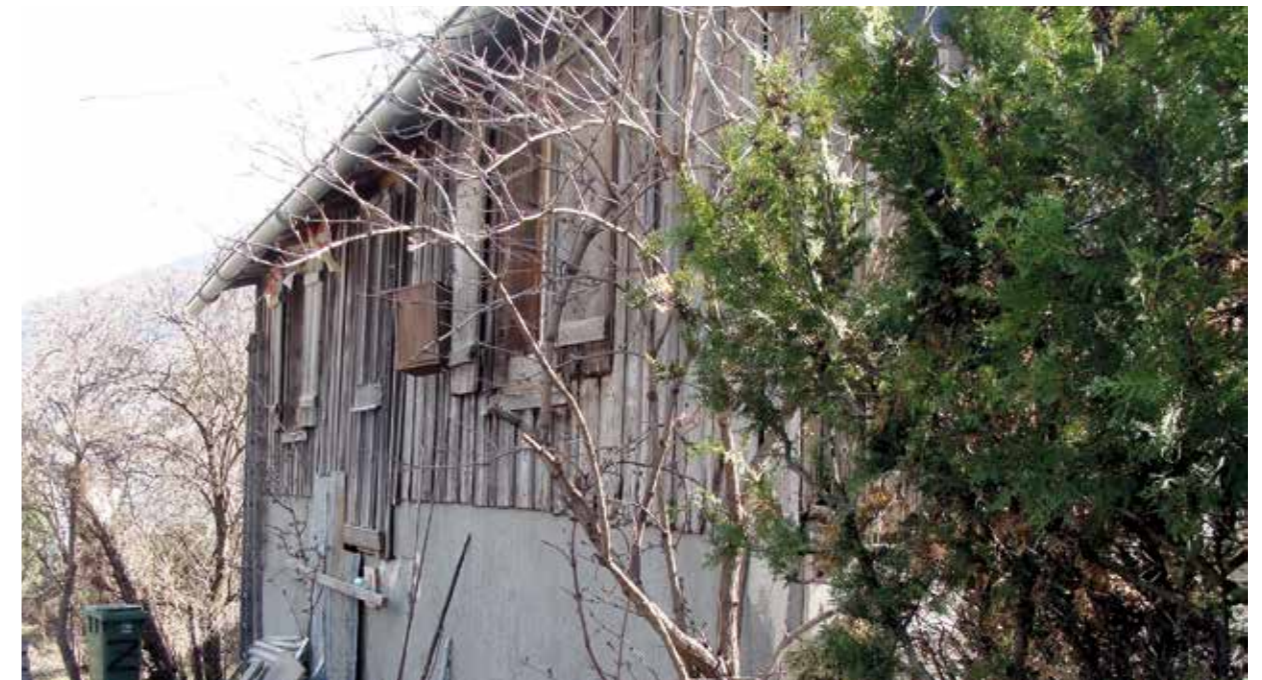
Der alte Schützenstand im Abendlicht (Nordseite) 2024
