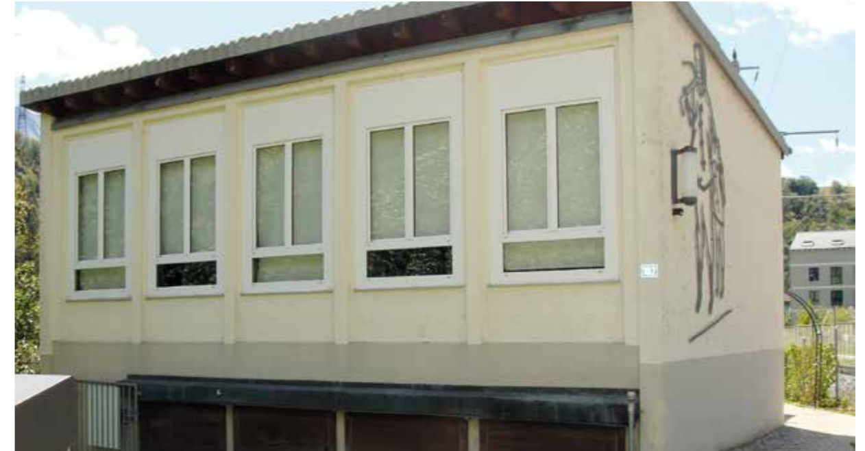
Standort Schützenstand: Beim Umbau zu einem Eventlokal wurden die 5 Schiessluken mit neuen Fenstern ausgestattet.
