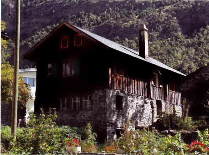
Links und rechts des Heidenkreuzes sind zwei kleine Fenster zu sehen, welche sicher erst später eingesetzt wurden, da hier das Holz noch neu ist. Bevor diese Fenster dort eingesetzt wurden, befanden sich dort wahrscheinlich zwei so genannte „Seeluglotzjini“.
