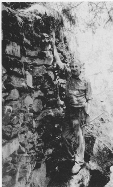
Die Mauern der Bärgeri sind teilweise mehr als 3 m hoch
