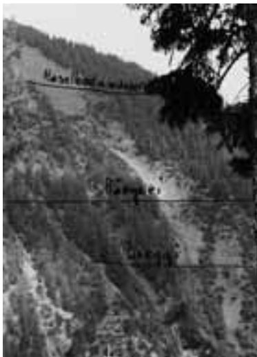
Drei Wasserleiten führten am linken Hang des Nesseltales Wasser: ds Haselboduwasser, di Bärgeri und ds Riseggi.
