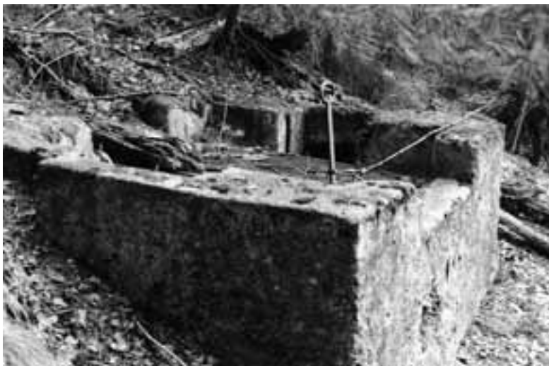
Bis 1984 gelangte das Wasser der Bärgeri nach dem steilen Lauf durch den Gliserwald auf diese Abschalte, wo es Richtung Holzji oder Richtung Wickert geleitet wurde.
