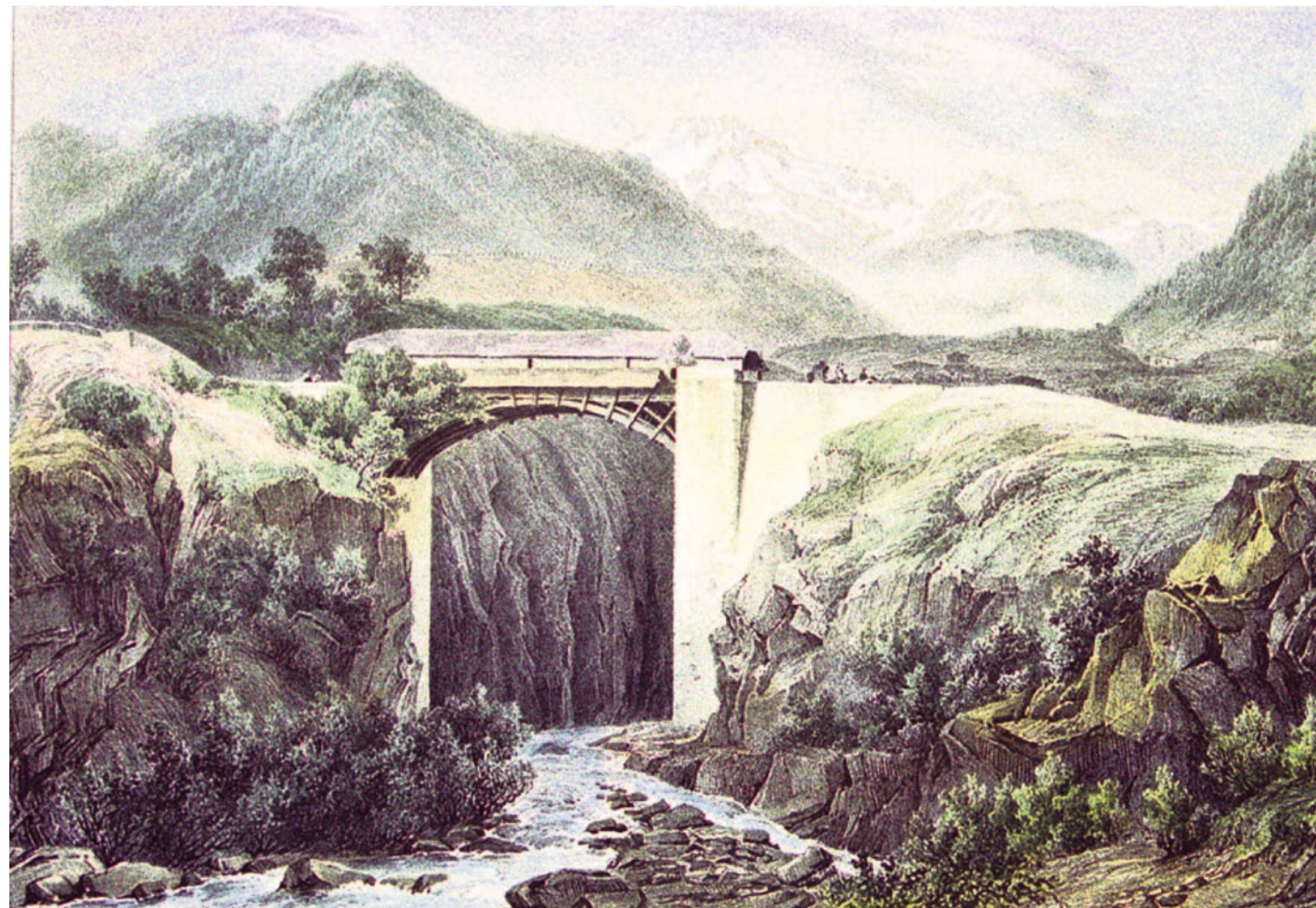
Napoleonsbrücke. Strasseninspektor Céard verwarf die Pläne Lescots und setzte jenes Bauwerk über die Saltinaschlucht, dem es, würde es in seinem Originalzustand noch bestehen, an Bewunderern nicht mangeln würde.
