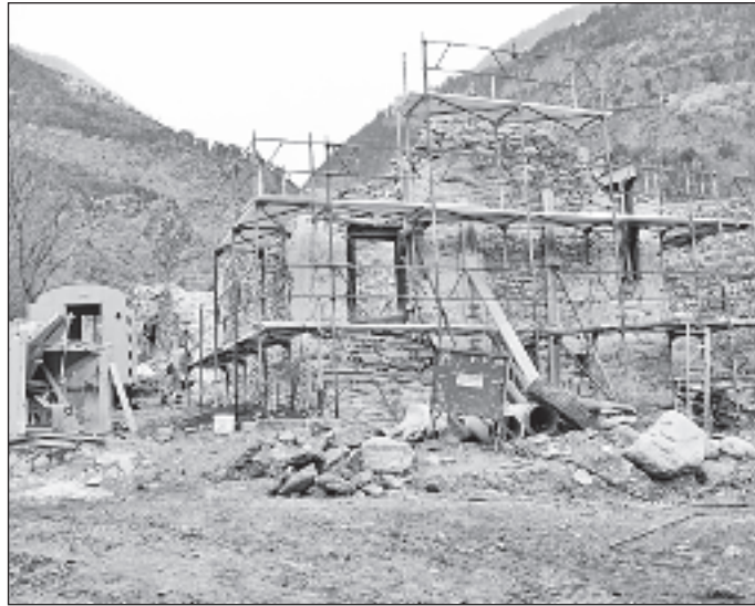
Die Alte Scheune/Suste an der Landmauer Gamsen: Die Renovationsarbeiten schreiten voran.
