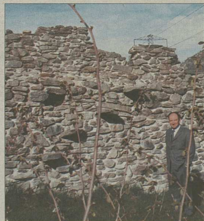
Die Bauweise bezeugt den wehrhaften Charakter der einstmals 850 m langen Talsperre. Im Bild: Heli Wyder, Stiftungsratspräsident.
