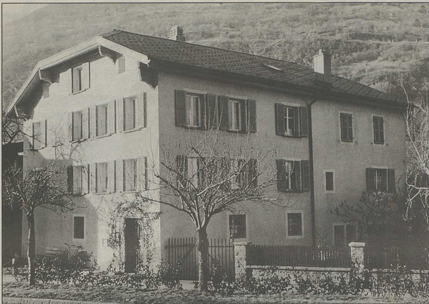
Die ältesten Mauern des alten Pfarrhauses reichen bis ins Gründungsjahr der Eidgenossenschaft (1299) zurück. Unter Verwendung eines Vorgängerbaus hat Johann Kleinmann, als einer der mächtigsten Politiker im alten Wallis, das Gebäude 1546 umfassend umgestaltet, und er wird als eigentlicher Bauherr des Pfarrhauses genannt. Das heutige Erscheinungsbild erhielt das Haus mit der baulichen Erweiterung im Jahre 1782.
