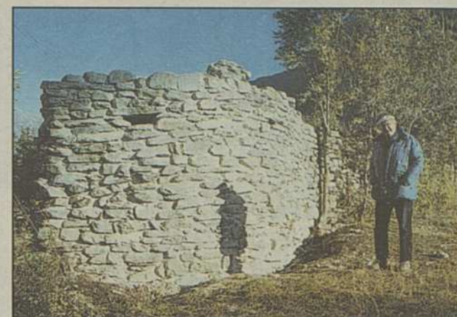
Detail aus der sanierten Landmauer.
